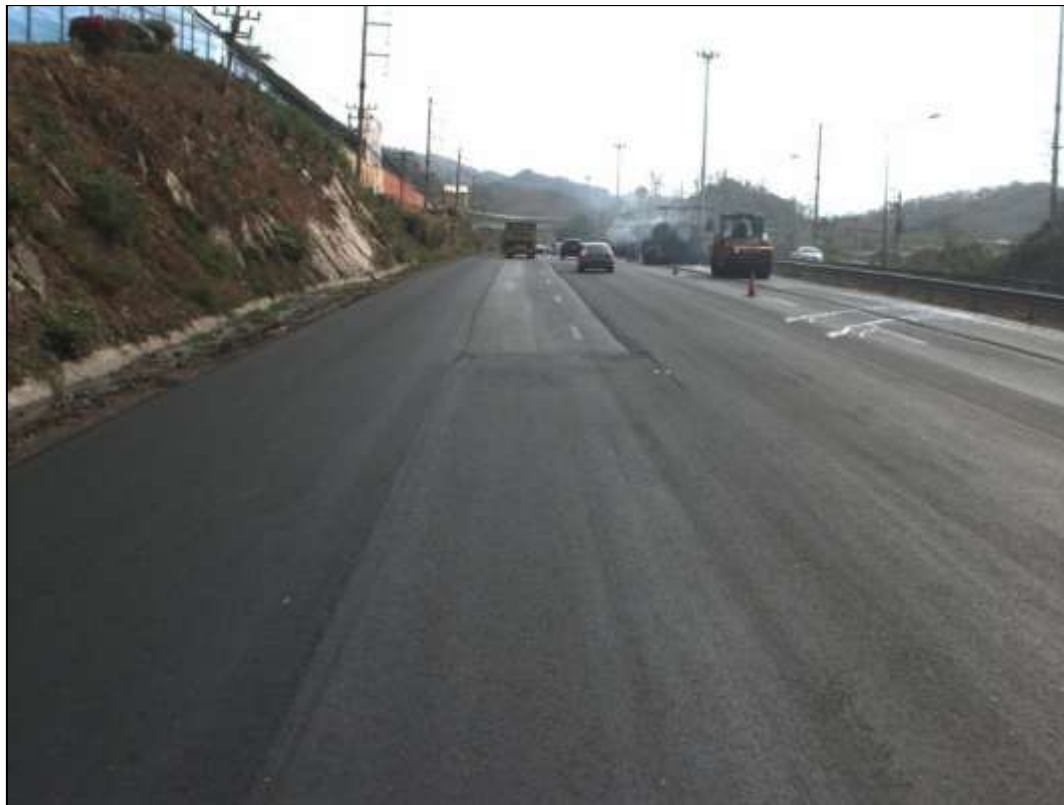
รูปที่ 1-67 แสดงภาพงานก่อสร้างปูผิวใหม่ทับผิวทางเดิม
