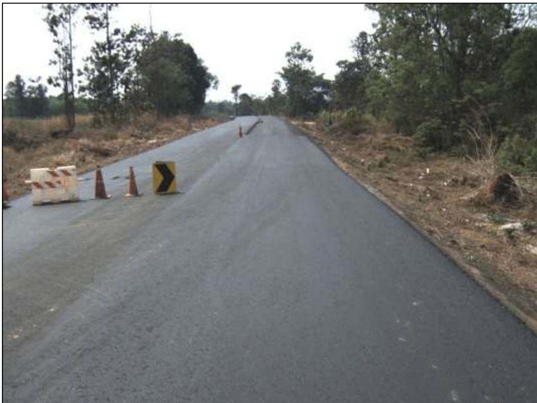
รูปที่ 1-65 แสดงภาพงานก่อสร้างปูผิวทางใหม่
