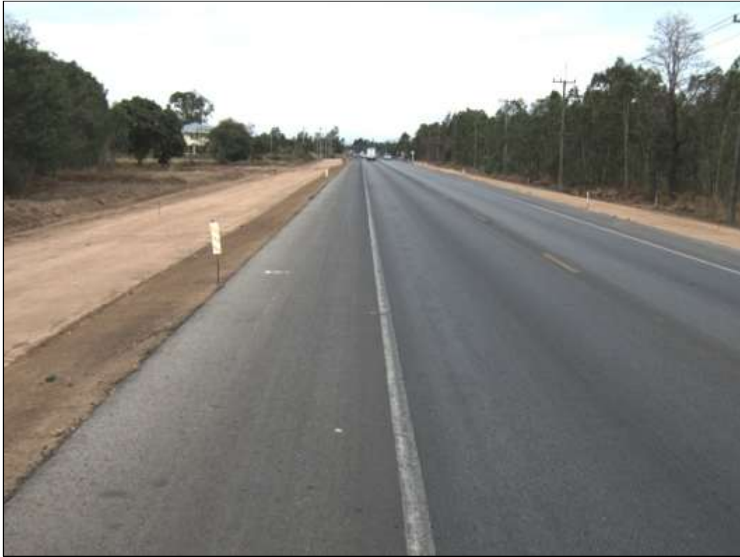
รูปที่ 1-66 แสดงภาพงานก่อสร้างขยายช่องจราจร
