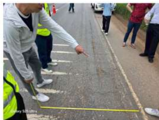
รูปที่ 1-166 รายละเอียดความเสียหายผิวลาดยาง แปลงทดสอบที่ 2.2 : จุดที่ 2 สายทาง 304-401 ช่วงกม. 145+375 เลน R2
